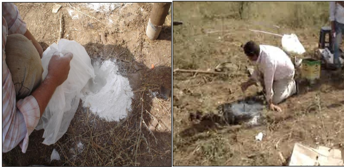
شكل رقم ( 44 ) تنفيذ الأوتاد الكلسية و ملؤها بالكلس المطحون
