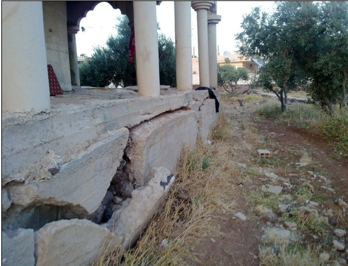
شكل رقم (23) الأضرار التي تسببها الترب الغضارية الانتفاخية على الأبنية ( منطقة الصنمين بدرعا )
