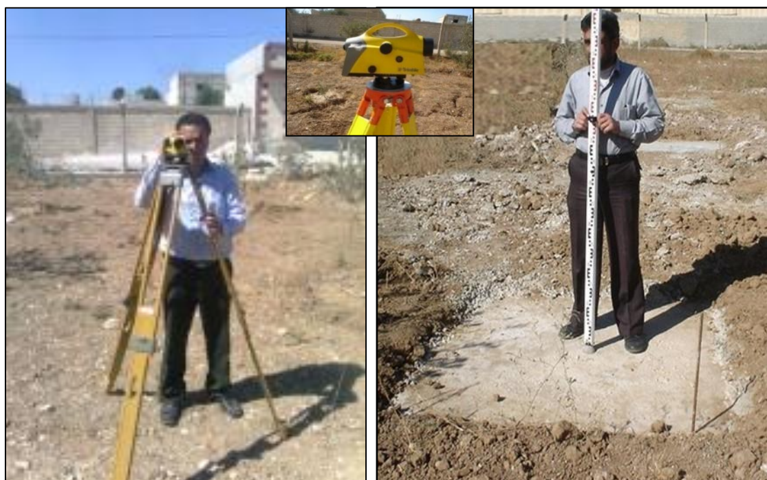
شكل رقم ( 55 ) مراقبة حركة المناسيب باستخدام جهاز نيفو دقيق
