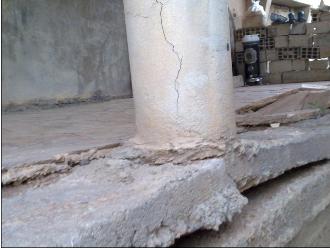
شكل رقم (24) الأضرار التي تسببها الترب الغضارية الانتفاخية على الأبنية ( منطقة الصنمين بدرعا )
