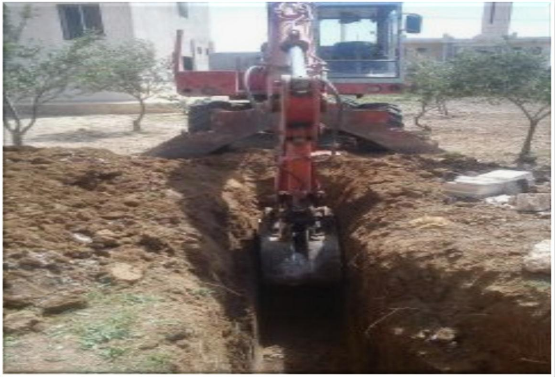
شكل رقم (14) الكشف عن الوتد الكلسي المنفرد .
