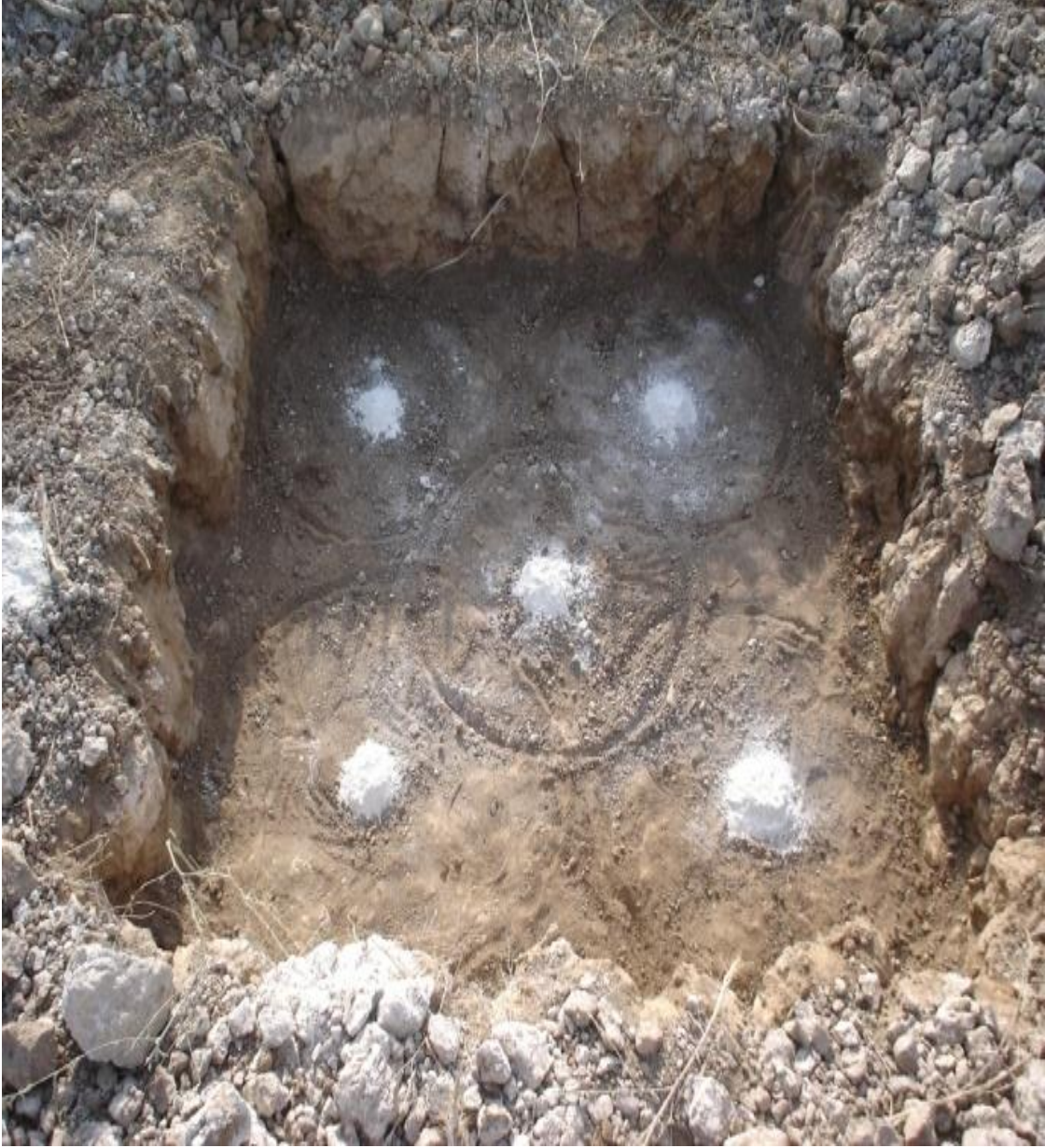
شكل رقم ( 45 ) الحفيرة اللازمة لتنفيذ البلاطة فوق الأوتاد الكلسية
